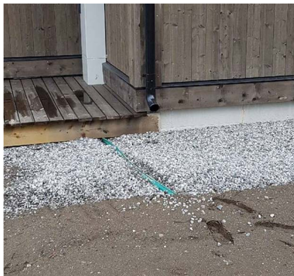
To eksempel på utilstrekkeleg overdekning av inntakskabel
